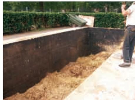
Il s'agit d'une fosse étanche enterrée ou semi-enterrée. Dans ce cas, la collecte des lixiviats n'est plus nécessaire, la fosse permettant déjà leur récupération.
