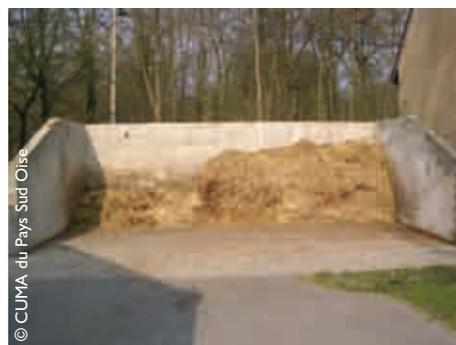
Le stockage sur aire étanche est le système classique rencontré dans la plupart des écuries. Il s'agit d'une aire bétonnée de 20 cm d'épaisseur au moins (350 kg/m<sup>2</sup> de ciment), en légère pente (2 %), avec collecte des lixiviats par point bas vers une fosse étanche.
